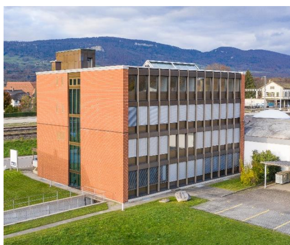
Zeughausstrasse 19, Wangen a. A.
